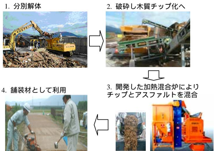
図1 木質廃材の舗装利用までの流れ
