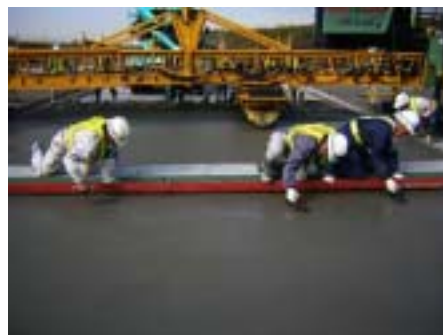
写真-4 施工状況（敷き均し、金ゴテ仕上げ状況）
