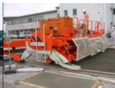
写真-2 薄層コンクリート打設 厚さ 5cm（手前はテストピット）
