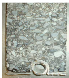
写真-1 空洞状況
