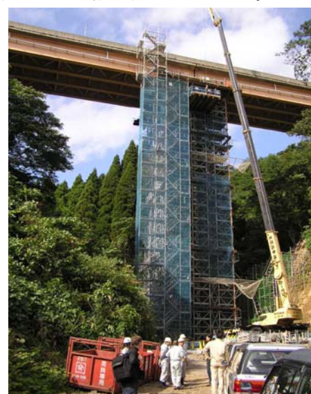
写真1 試験橋梁全景
