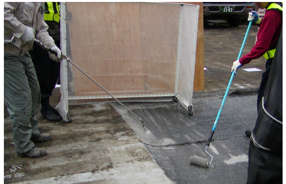
写真-1 試験施工状況
