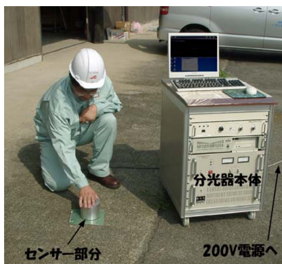
図3 NMR 表面スキャナーシステムをもちいた屋外計測作業のイメージ。図 2 のセンサー部分をコンクリートに押し当てて、表面から 1.5cm 奥にある水を計測する。右隣のラックは分光器本体で、3 相 200V 電源に接続される。
