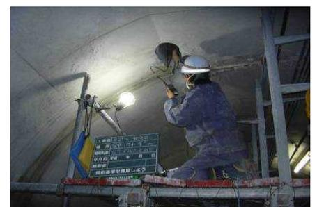
写真-2 セグメント残存厚測定作業
