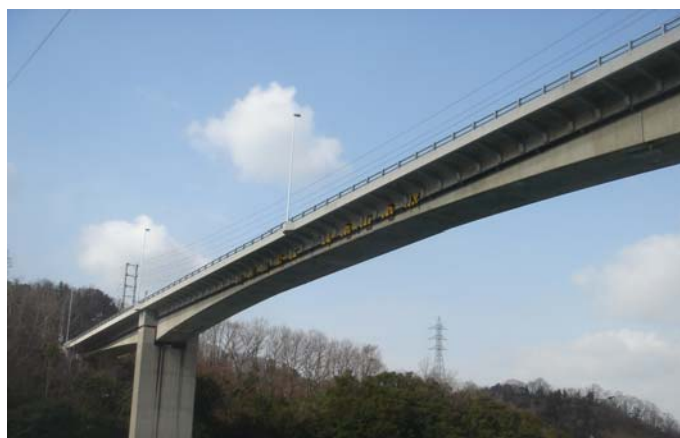
写真-4 工事完了
