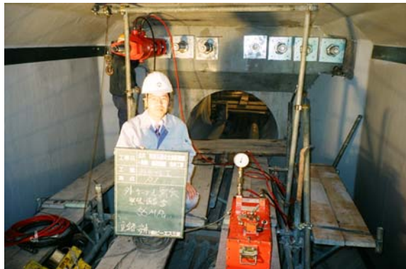
写真-1 外ケーブル定着状況
