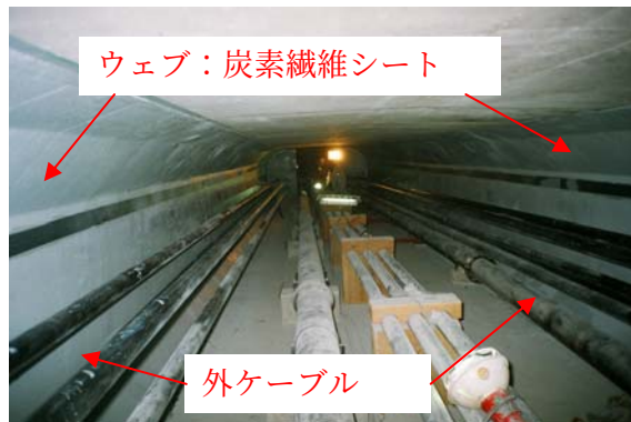
写真-2 主桁補強状況
