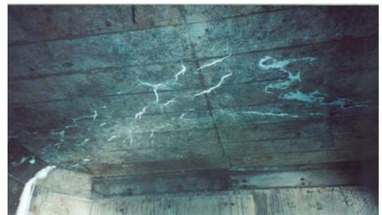
図-2 輪荷重を受けた床版の劣化状況
