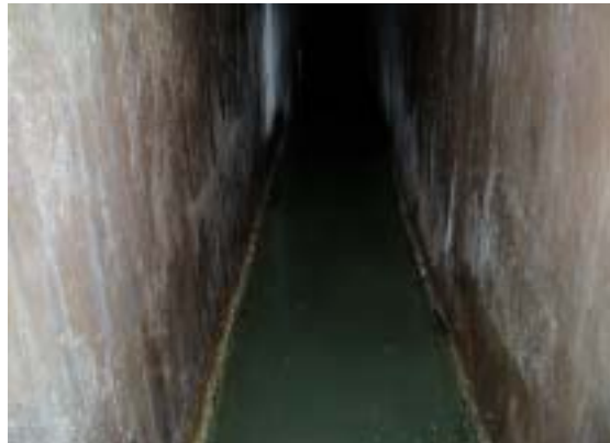
写真-4 施工後 2 年目の状況(M - 2)
