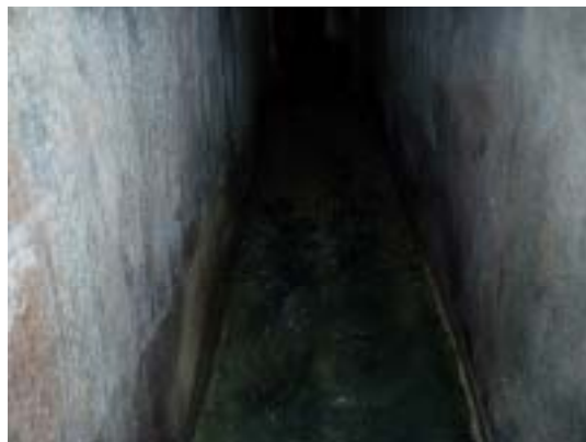
写真-3 施工後 2 年目の状況(M - 1)
