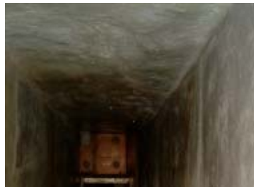
写真-2 耐硫酸モルタル施工後の流入水路
