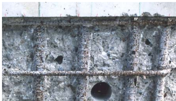
(a)変状箇所の上部の健全部の鉄筋の状態（補修時撮影）
