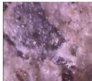
写真-1 表面改質材を塗布した供試体のひび割れ閉塞状況（ひび割れ幅 0.1mm）
