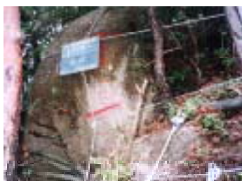
図5 ワイヤロープ掛工
