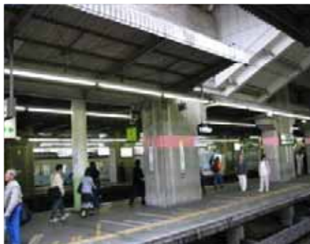
写真1 対象橋脚状況
