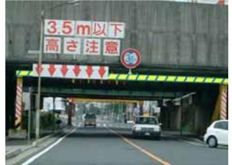
以上の結果を踏まえ、遠距離からの防護工の存在が認識できる塗色として、黄（蛍光色）を中心とし、近距離からの防護工の縁が確認できる塗色として、青（蛍光色）を今回新たに追加した。現在までの間は、当該箇所への橋けた防護工への衝突は発生していない。
