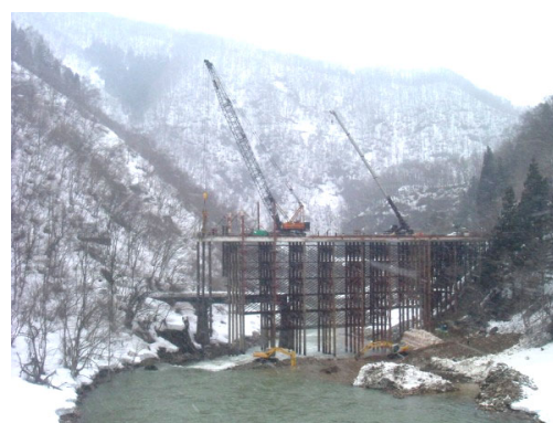
写真-2 第6宮川B復旧状況（H18.3）
