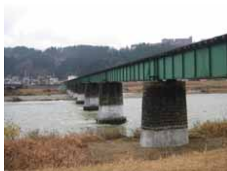
図 - 4 応急工事施工後（アラミド巻き）
