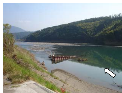
写真-2 第1鉄橋桁の流出状況
