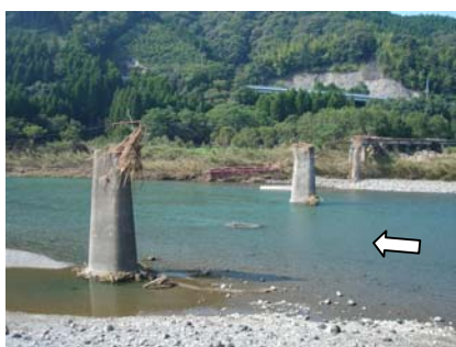
写真-1 第1鉄橋の被災状況
