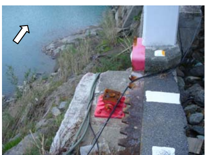
写真-9 小布所橋の支承部状況
