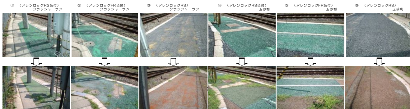
写真1 施工前後比較(施工5ヵ月後)
