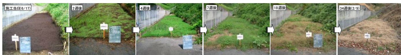
写真 4 経過状況(施工当日→34 週後(手前:試験地 A、奥:試験地 B))
