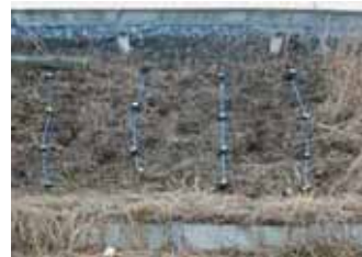
写真3 スパイラルネイリング工法
