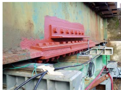
写真 5 添接板施工状況
