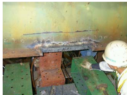
写真 3 下フランジ切断状況
