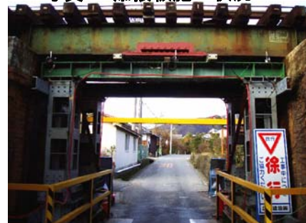
写真 6 門型ベント設置状況
