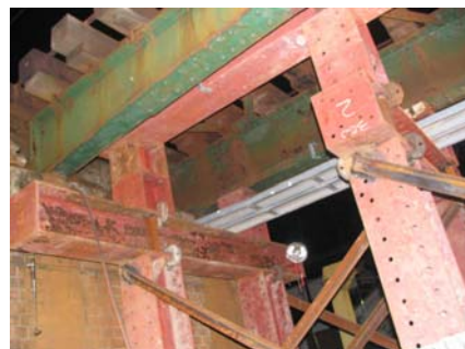
写真 2 仮受け桁設置状況
