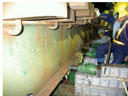
写真 4 桁矯正状況
