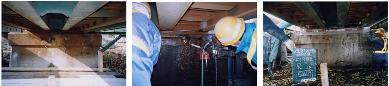
写真-3 沓座モルタル施工状況
