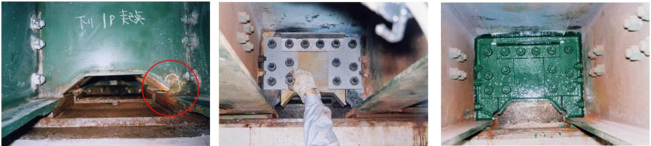
写真-2 横桁添接継手構造による施工状況
