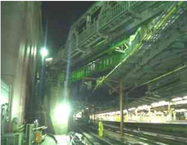
写真－2 床組み撤去状況
