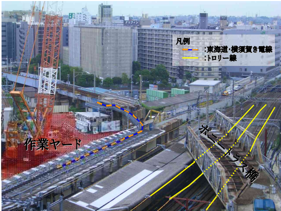
写真－1 ポニートラス橋架設状況
