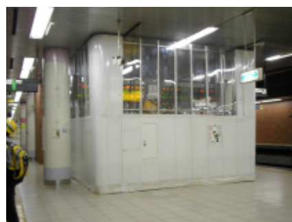
写真-3 仮囲い設置状況
