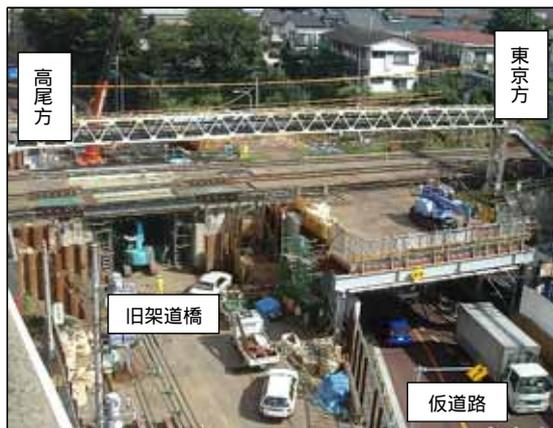
図-1 改築前の架道橋と仮道路
