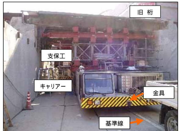
図-4 キャリアー上の支保工と走行基準線
