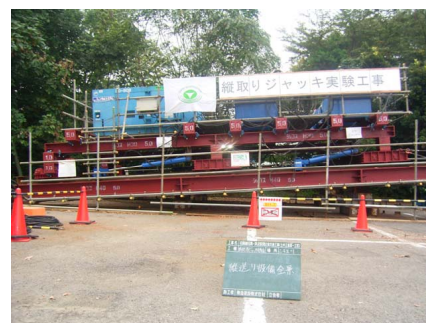
（写真-1）緊急時縦引き装置試験状況
