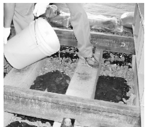
写真2 軌道へのポリマー散布状況
