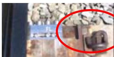
図1 ローラーベアリング床板
