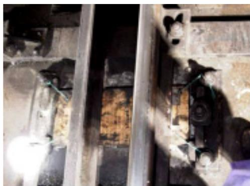
写真-1 モルタル填充および型枠設置
