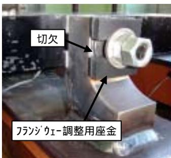
図3 フランジウェー調整用座金の形状変更
