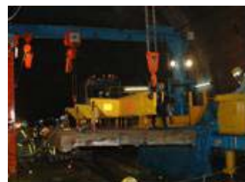
写真4 吊金具(6点式)
