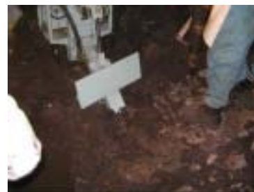
写真6 はつり機（試験施工）
