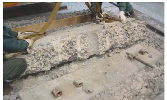
写真-1 填充層撤去時の様子
