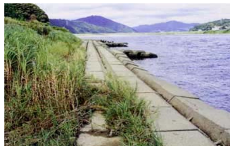
写真1 多自然型川づくり施工前の山路箇所 2)
