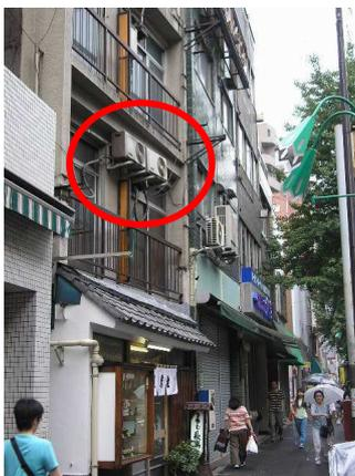
写真1 落下の恐れのある室外機や歩道上に倒壊の恐れのある建物群
