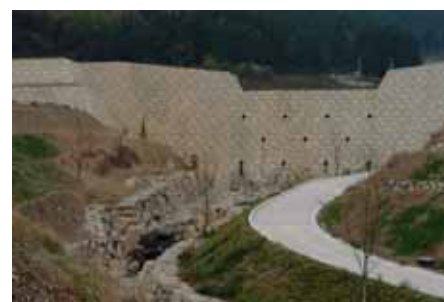
写真 - 1 1号砂防堰堤
