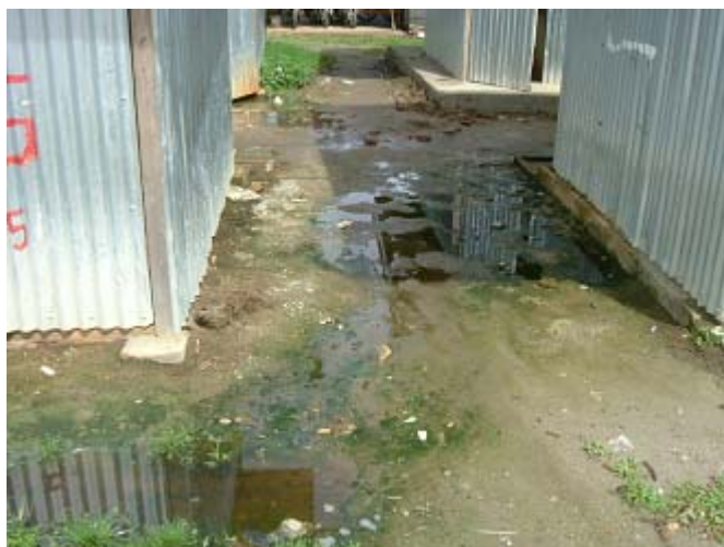
写真3 仮設住宅の排水状況
