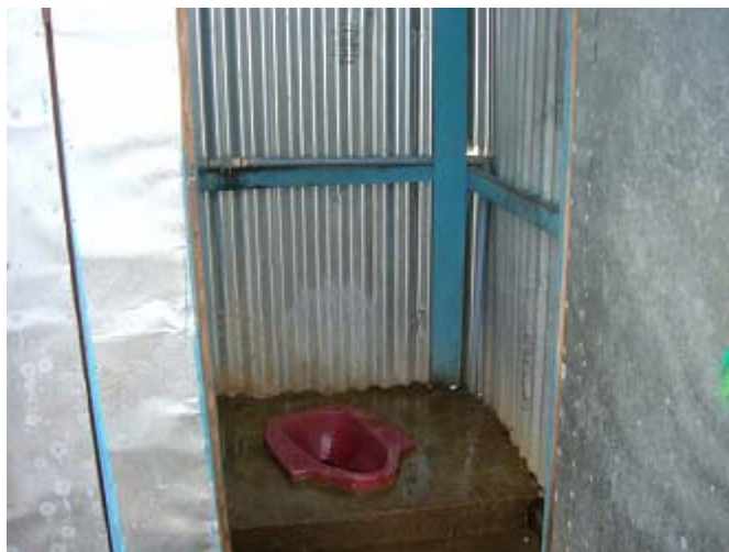
写真2 仮設住宅の標準的なトイレ
