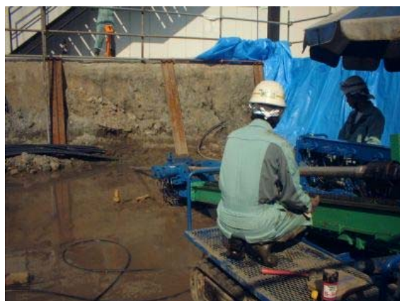
写真-3 ボーリングを行っている様子
