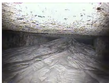
写真-2 空洞カメラによる坑内の端部材の充填状況
