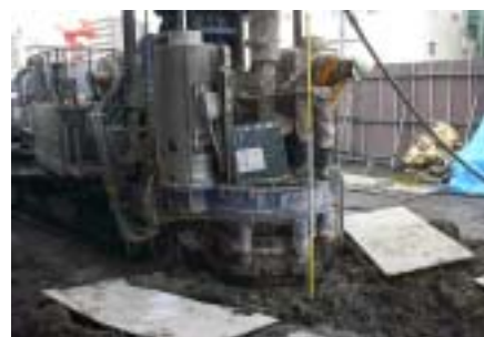
写真1 施工状況(先行削孔+置き換え工法)
