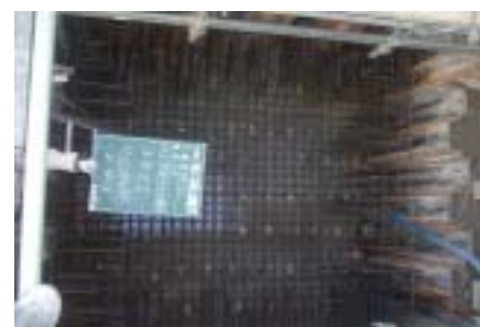
写真2 フーチング鉄筋組立状況
