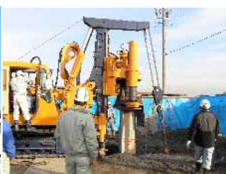
反力装置を使用した施工
