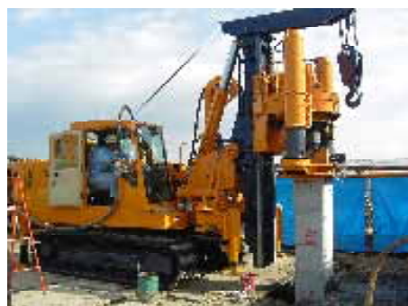
中掘施工状況
