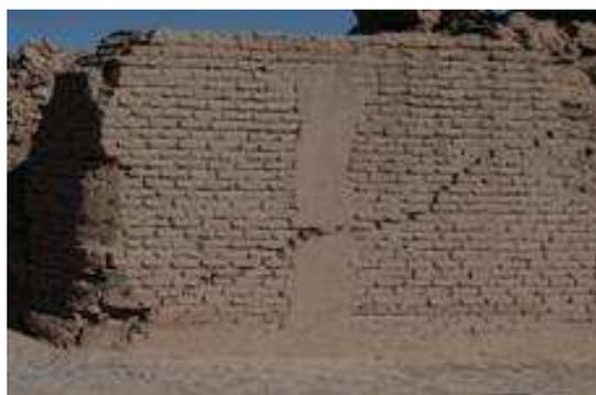
図-1 地震により亀裂が発生した日干し煉瓦壁面
