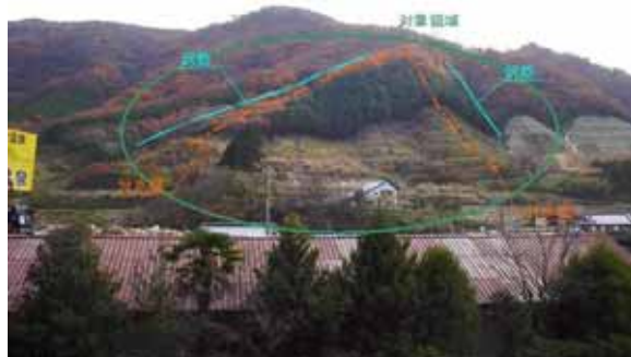
写真-1 対象斜面の全景
