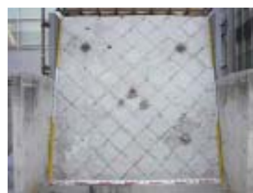
写真1 実物石積壁の全景
