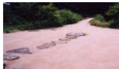
図-1 舗装材の施工例
