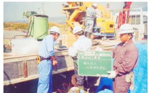
写真－1 スラリーの製造状況
