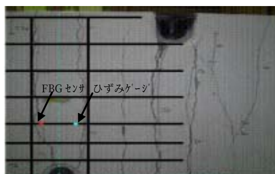
写真2 ひび割れの発生状況
