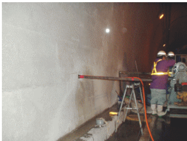
写真-1 応力測定状況
