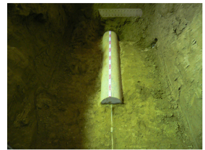
写真1 アンカー体設置（ケース4）
