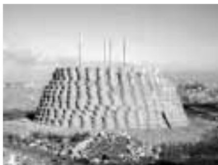
写真-1 施工終了直後の試験盛土
